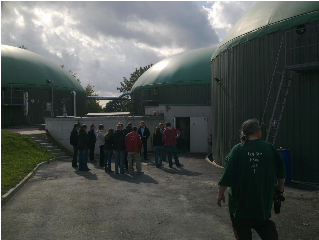
Abb. 2: An der Biogas-Anlage Grimma-Beiersdorf.
