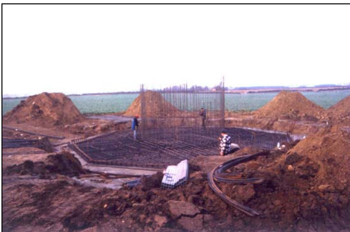
Abbildung 14: Fundament einer WEA der 1,5 MW-Klasse im Windpark Kleptow/ Klockow.
