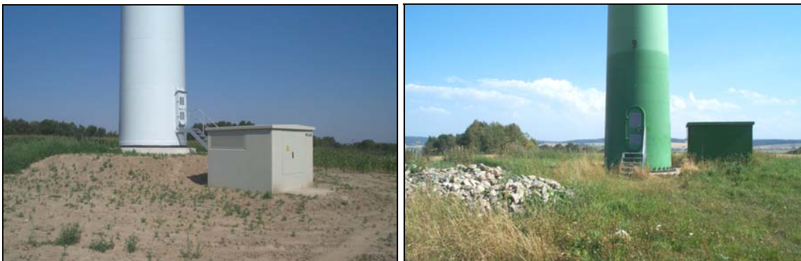
Abbildung 16: Windpark Rabenstein und WEA Zwönitz. In den beiden Fotos sind die Fundamente, die Trafostationen und Mastfüße der Windenergieanlagen zu sehen. Im Unterschied zur WEA im linken Bild sind bei der Anlage im rechten Bild Vermeidungs- und Minderungsmaßnahmen, wie farbliche Anpassung des Turmschaftes und der Trafostation sowie Begrünung des Fundamentes berücksichtigt worden.
